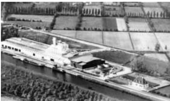
Afbeelding 53: luchtopname van de kunstmestfabriek met rechtsonder de directeurswoning .
