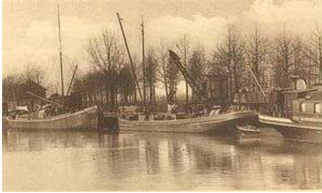
Afbeelding 52: de spoorhaven in Veghel, met een havenkraan voor de overslag van trein naar schip.
