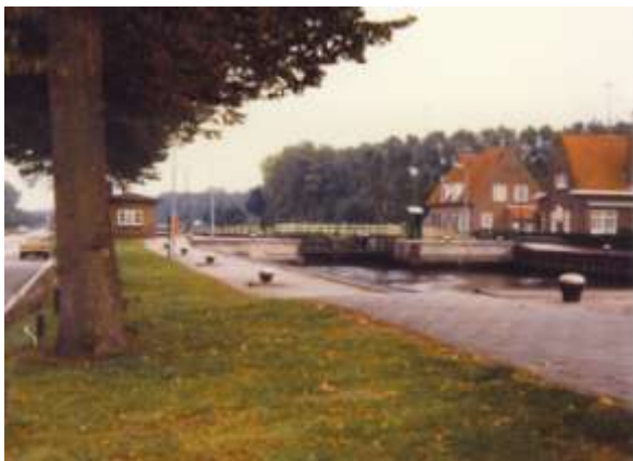
Afbeelding 14: Sluis 3 in de Zuid-Willemsvaart met de sluiswachterswoningen.
